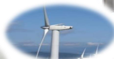
風力発電 地中配線
